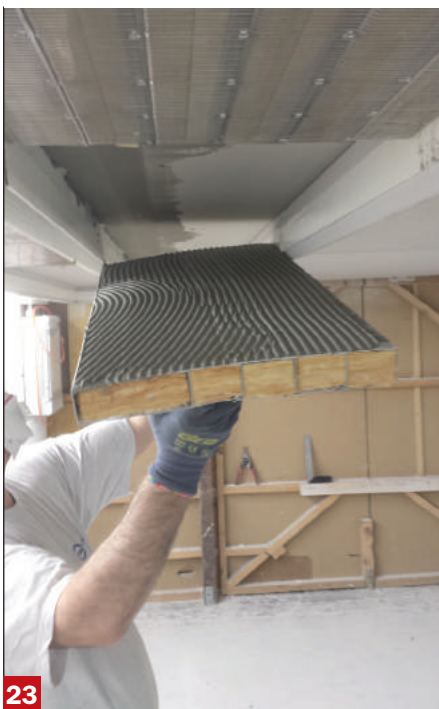
Plaatsing en afwerking van akoestisch thermisch geleidende panelen
