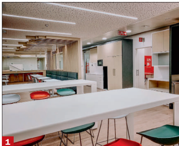
Akoestisch klimaatplafond met geperforeerde gipsplaten
